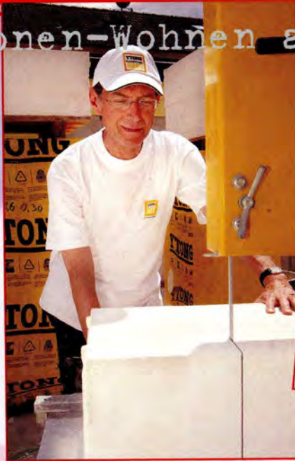
Die leichten Steine lassen sich problemlos anheben und platzieren. Pass-Stücke werden mit einer elektrischen Bandsäge einfach auf das gewünschte Maß zugeschnitten.
